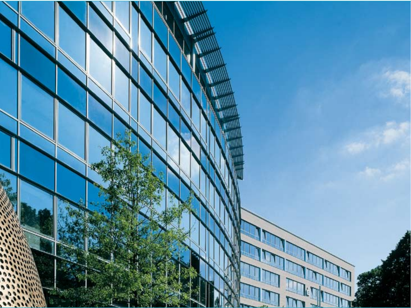
Imposante Fassade im Dialog mit der Umwelt: Die Stadtsparkasse Wuppertal mit der harmonischen Anpassung von INFRACLAD® E 100 an INFRASTOP® Neutral.
